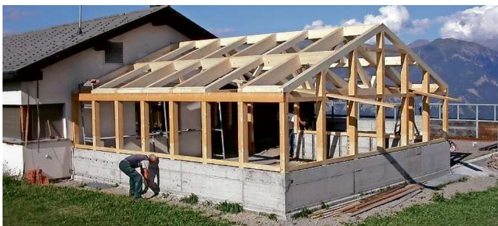
Ein Teil der Terrasse wird zum Wintergarten ausgebaut.
